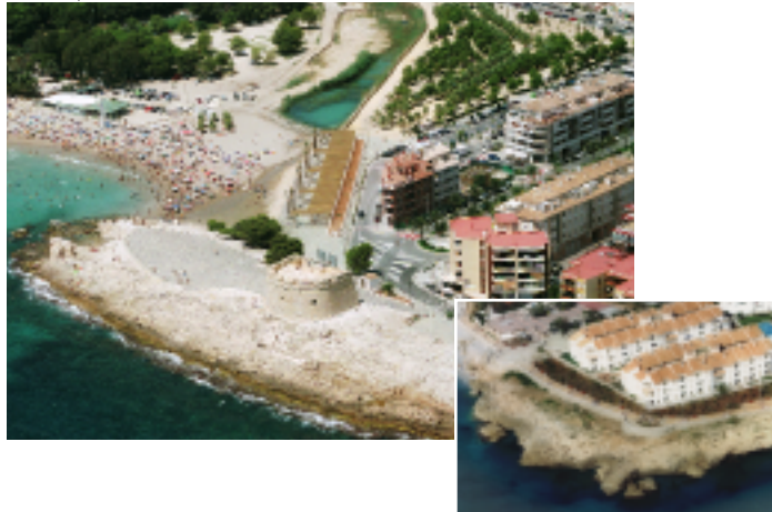
RECUPERACIÓN AMBIENTAL DE LA FRANJA COSTERA DE TEULADA ALICANTE
