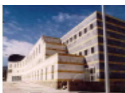
CENTRO TECNOLÓGICO ANDALUZ DE LA PIEDRA EN MACAEL ALMERÍA
