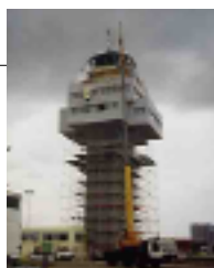
REMDELACIÓN TORRE DE CONTROL AEROPUERTO DE SANTANDER SANTANDER
