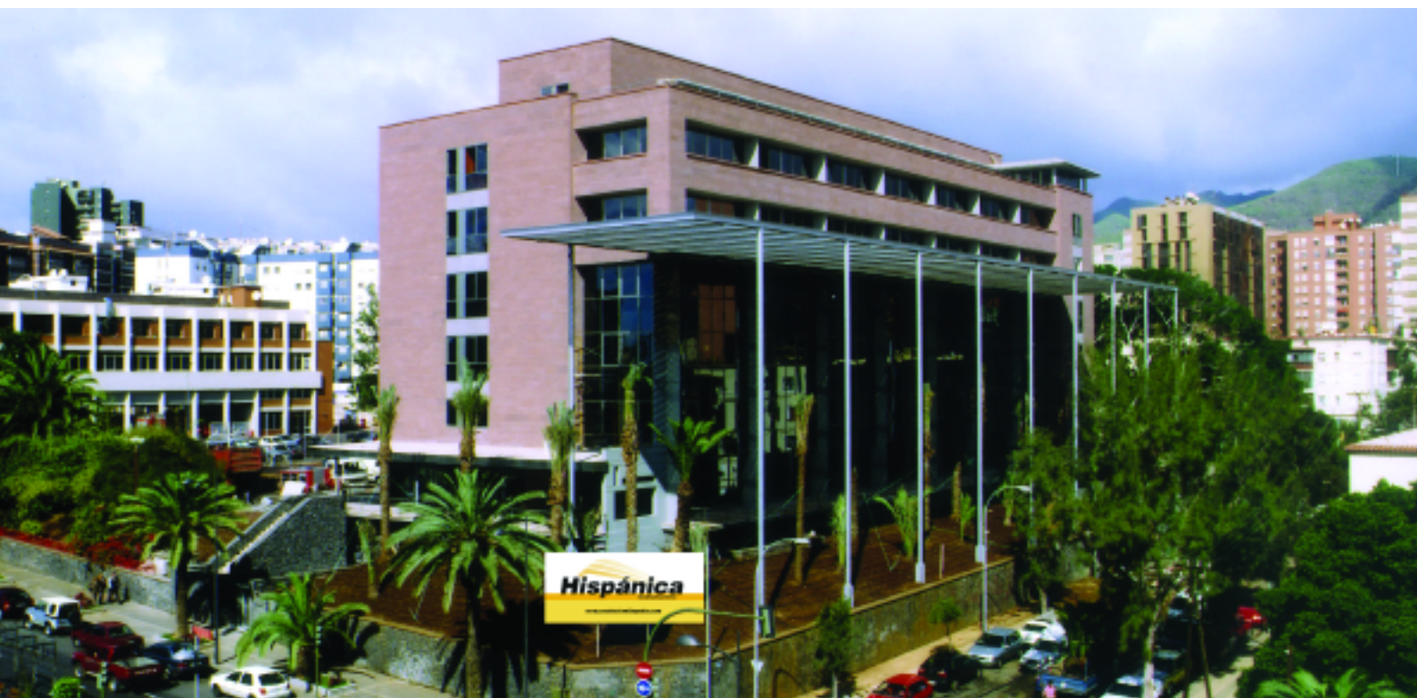
EDIFICIO DE OFICINAS SEDE DE GERENCIA DE URBANISMO SANTA CRUZ DE TENERIFE
