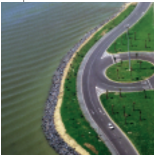
GLORIETA DE GIRO EN LA AVDA. FRANCISCO MONTENEGRO HUELVA
