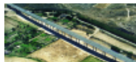
AVE TRAMO MADRID - BARCELONA ZARAGOZA
