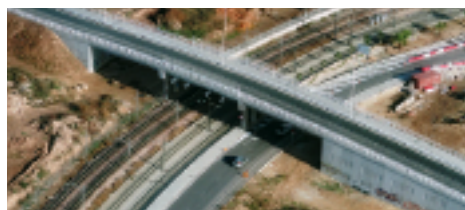
SUPRESIÓN DEL PASO A NIVEL DE LA LÍNEA 1 (LLIRIA-EMPALME) EN BURJASSOT VALENCIA
