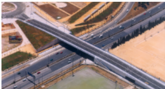
ESTRUCTURA SOBRE LA AUTOVÍA SE-30 Y URBANIZACIÓN EN LA ZONA "PALMETE" SEVILLA
