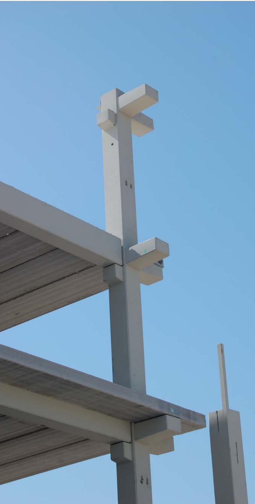
Ménsulas para apoyo de jácenas de forjado y voladizos
