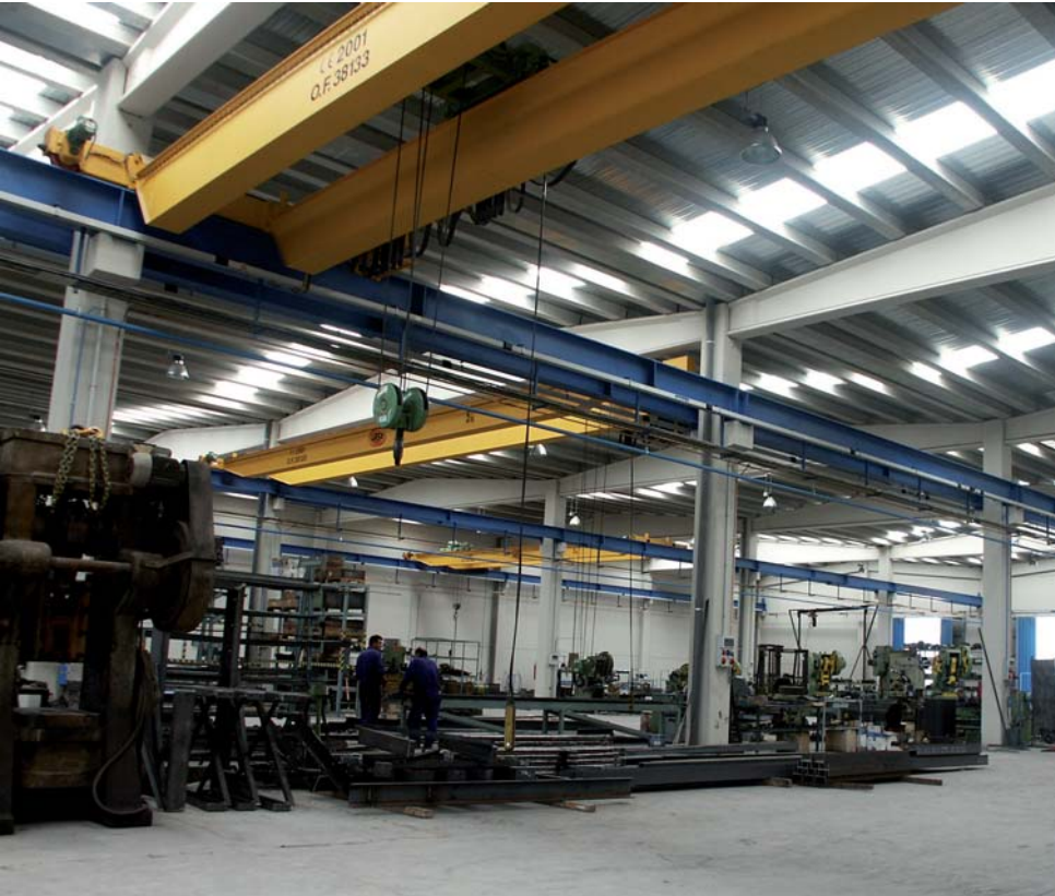
Ménsula para apoyo de puente grúa
