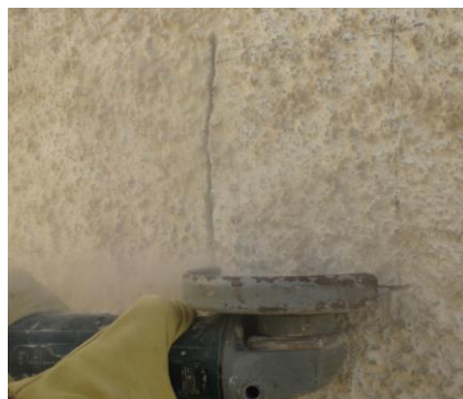
Imagen 49 Marcado y corte mediante disco de cata de fachada
