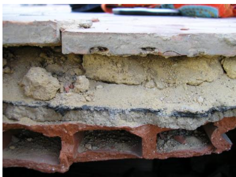
Imagen 54 Identificación de materiales en cata de cubierta plana
