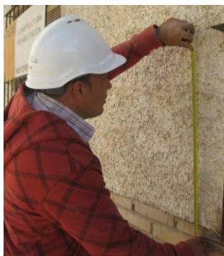
Imagen 49 Marcado y corte mediante disco de cata de fachada
