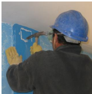
Imagen 52 Apertura de cata de fachada próxima a pilar y/o forjado
