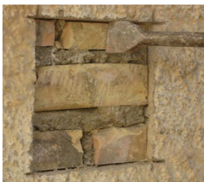
Imagen 49 Marcado y corte mediante disco de cata de fachada
