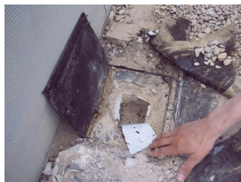
Imagen 53 Apertura de cata de cubierta plana
