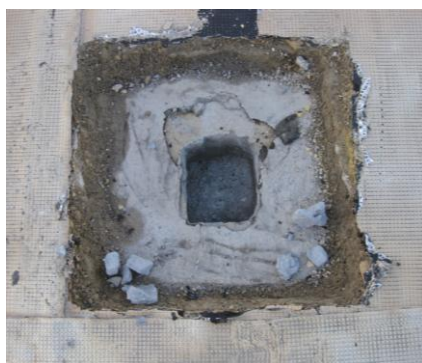
Imagen 53 Apertura de cata de cubierta plana
