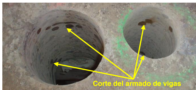
Fig. 11 y 12. Apertura de huecos en elementos estructurales (vigas y viguetas) para paso instalaciones. INCORRECTO.
