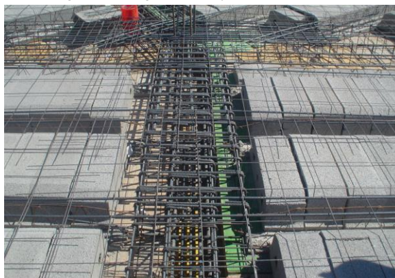
Fig. 2: Forjado unidireccional con semiviguetas
