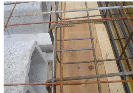
Fig. 17 y 18. Apoyo sobre viga de canto. Enlace por solapo
