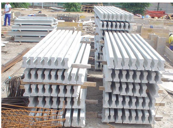
Fig. 4. Acopio de viguetas sin identificación
