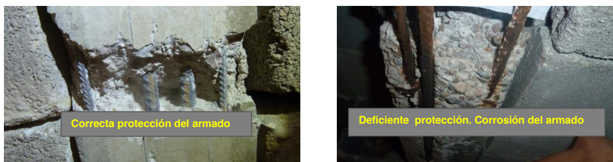
Fig. 32 y 33. Comportamiento de los recubrimientos del armado de viguetas, según espesores y/o calidad del hormigón
