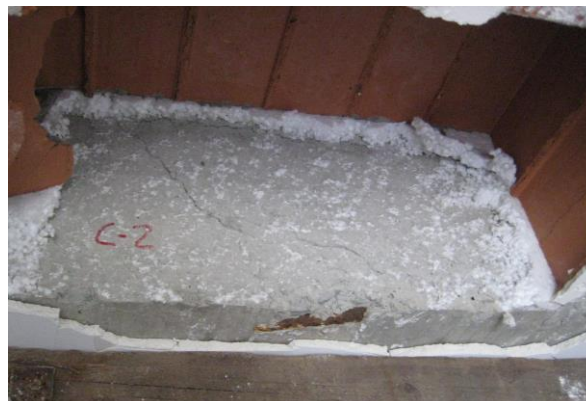
Figura 19. Fisuración en viga por esfuerzo cortante
