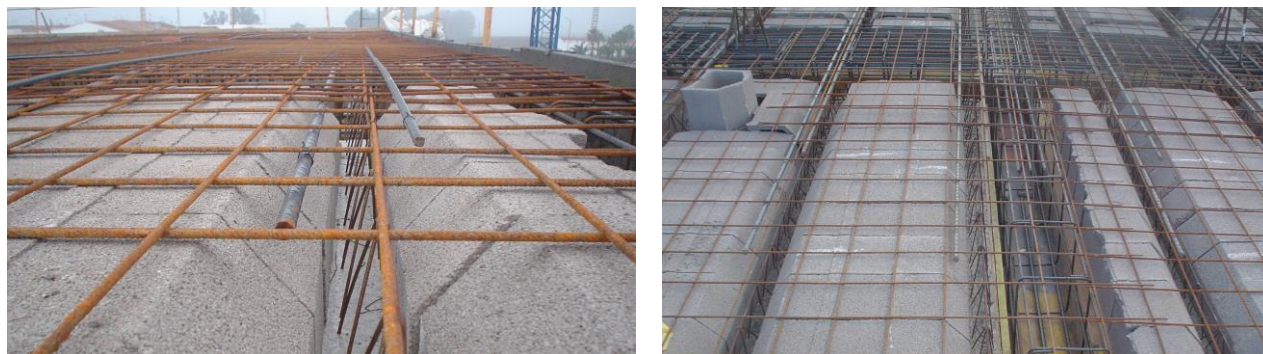
Fig. 29 y 30. Colocación armado de negativos y mallazo de reparto
