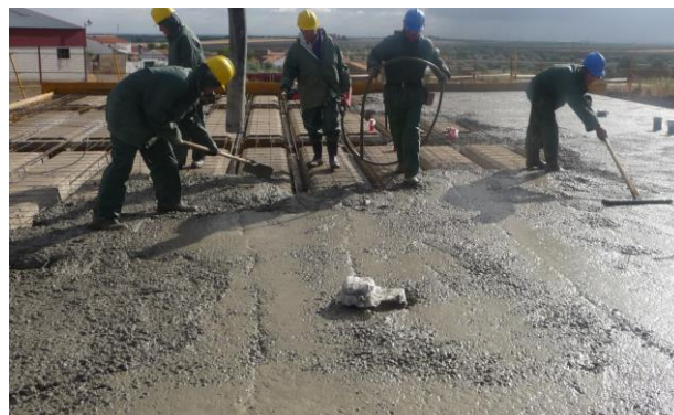
Fig. 35 y 36. Fase de hormigonado de forjado
