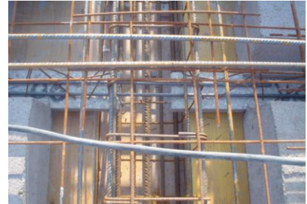
Fig. 13 y 14. Apoyo sobre viga de canto. Enlace por entrega
