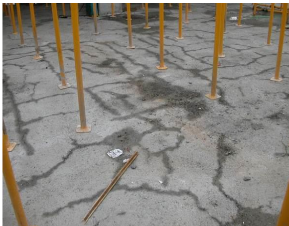
Figura 15. Fisuración por retracción hidráulica
