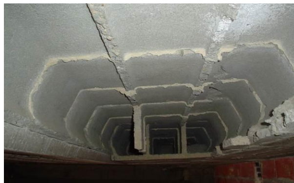
Figura 14. Rotura y desprendimiento de bovedillas de hormigón por deformaciones diferenciales
