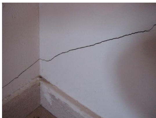
Figura 9. Lesiones en tabiquería por deformaciones excesivas de forjados
