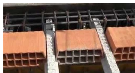
Fig. 27 y 28. Apoyo sobre viga plana. Enlace por entrega
