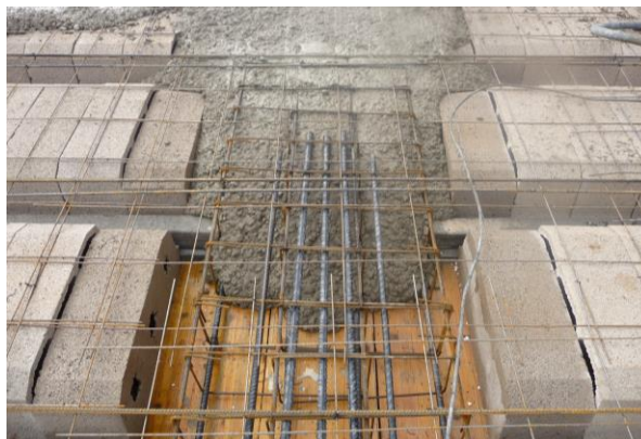
Fig. 2: Hormigonado forjado unidireccional
