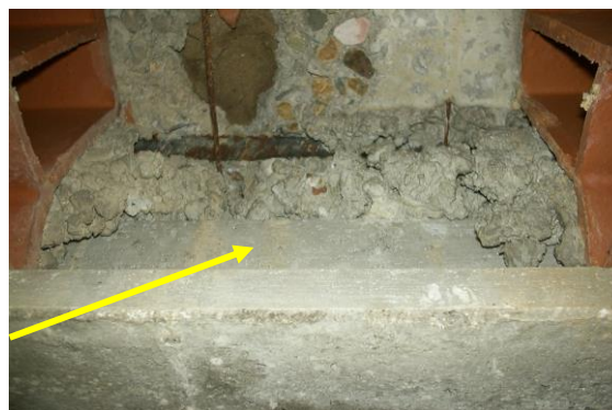
Figura 8. Deficiente vertido y compactado del hormigón entre vigueta y bovedilla
