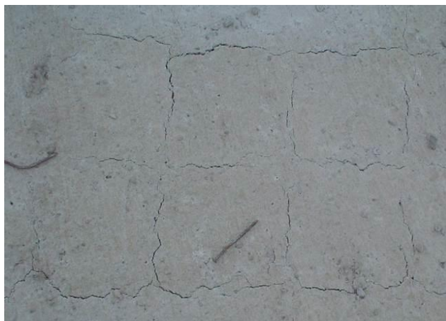
Figura 16. Fisuración por asiento plástico
