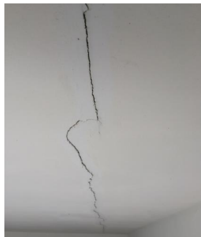
Figura 18. Fisuración en cara inferior de forjado por cambio de rigidez de viguetas
