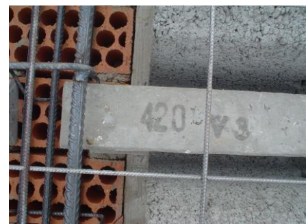
Fig. 19 y 20. Apoyo sobre muro de carga. Enlace por entrega
