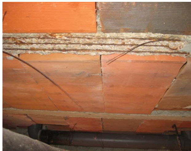
Fig. 12 y 13. Corrosión de la armadura y desprendimiento del hormigón de vigueta
