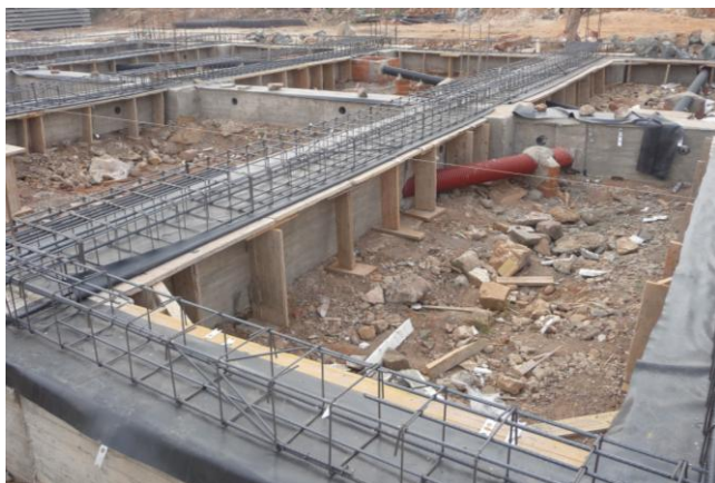
Fig.20 y 21. Barrera de corte de humedad en muros de apoyo forjado sanitario
