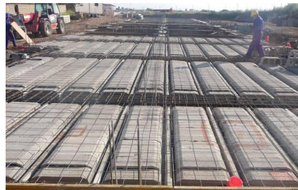
Fig. 2: Vista general forjado sanitario
