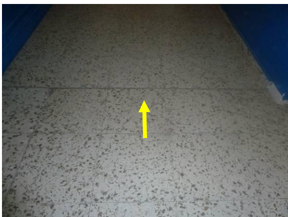
Fig. 10 y 11. Lesiones en el solado: Marcado de juntas, desprendimiento del rodapié
