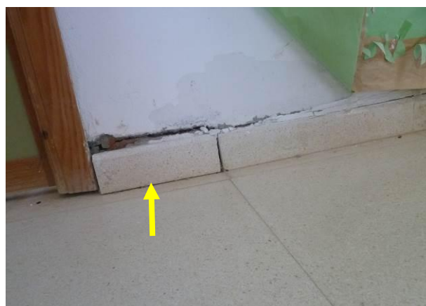
Fig. 10 y 11. Lesiones en el solado: Marcado de juntas, desprendimiento del rodapié
