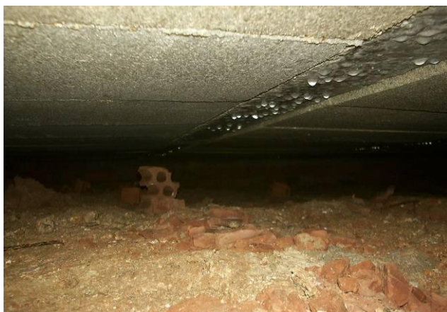
Fig. 4. Ausencia ventilación cámara sanitaria. Condensaciones
