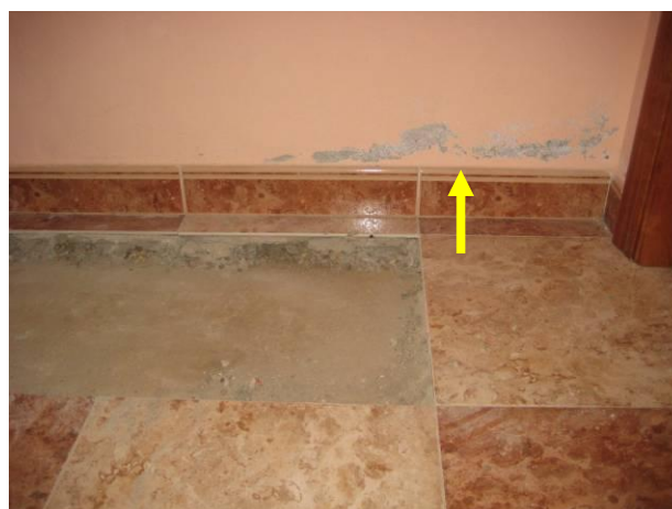
Fig. 15. Humedad por capilaridad
