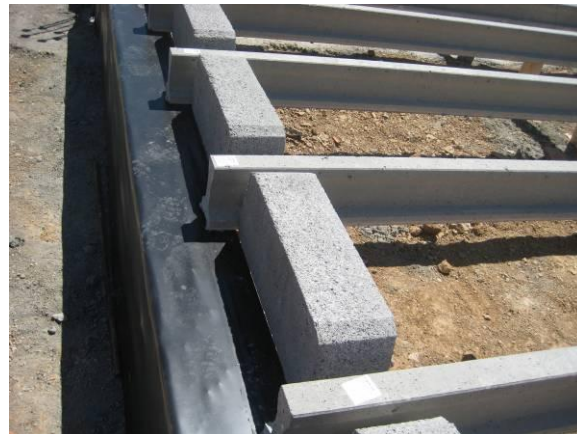
Fig.20 y 21. Barrera de corte de humedad en muros de apoyo forjado sanitario
