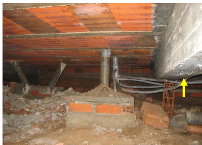
Fig. 14. Ausencia ventilación cámara sanitaria. Condensaciones en cara inferior de la viga de hormigón
