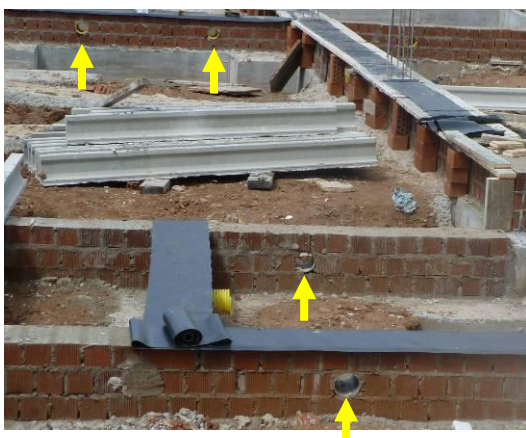
Fig.22 y 23. Apertura de ventilación en muros y/o vigas bajo forjado sanitario
