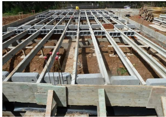
Fig. 1: Vista general montaje viguetas forjado sanitario
