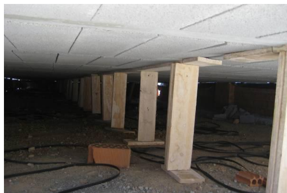
Fig. 17. Sopandado provisional forjado sanitario
