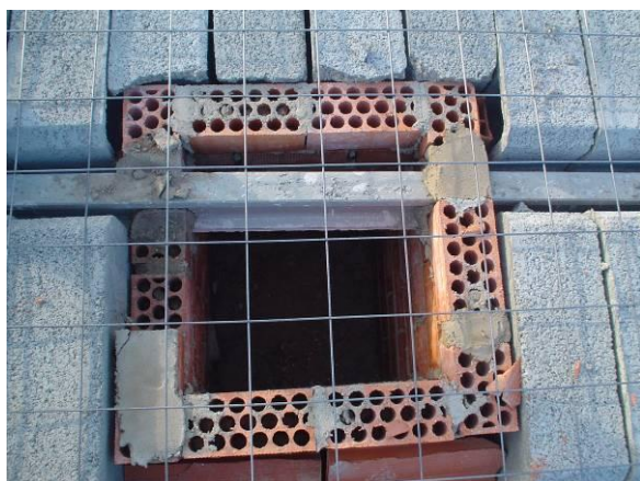
Fig. 18. Replanteo arquetas saneamiento. Incorrecto
