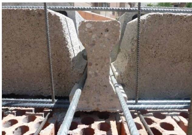
Fig. 6. Apoyo viga sobre armado inferior de zuncho con ausencia de recubrimientos. Incorrecto
