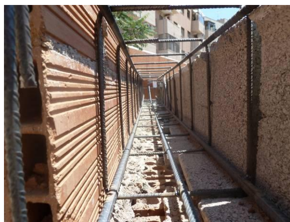
Fig. 7. Ausencia de recubrimientos del armado de zuncho lateral de forjado sanitario. Incorrecto
