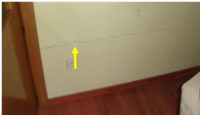
Fig. 8. Fisura en tabiquería por deformaciones excesivas de forjados
