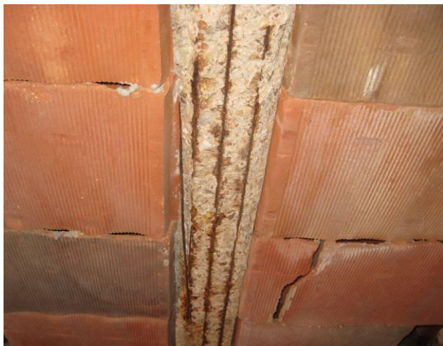
Fig. 12 y 13. Corrosión de la armadura y desprendimiento del hormigón de vigueta
