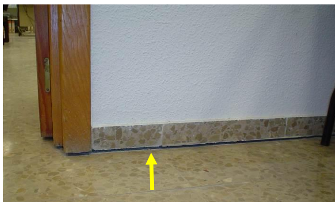
Fig. 9. Separación tabique-solado por deformación del forjado
