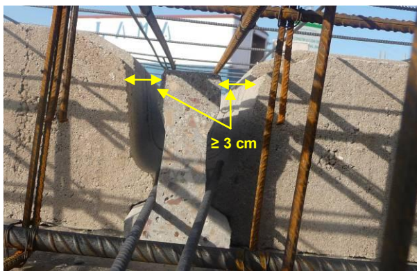
Fig. 16. Compatibilidad viga-pieza entrevigado
