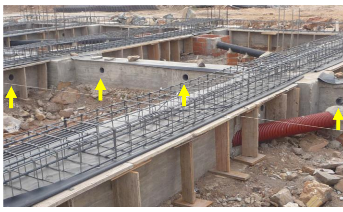
Fig.22 y 23. Apertura de ventilación en muros y/o vigas bajo forjado sanitario
