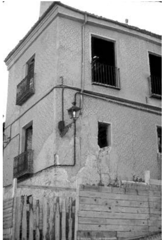
Foto nº 5: Pandeo en muros de fachada
