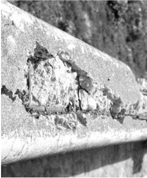
Foto nº 25: Rotura en pasamanos de pretil de H.A. (oxidación)
