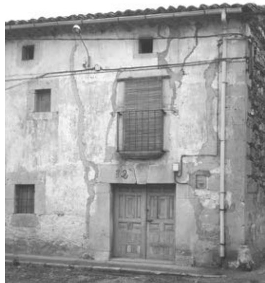
Foto nº 18: Efectos de las arcillas expansivas
