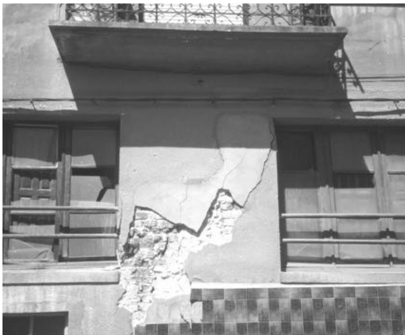
Foto 20: Rotura a compresión en machón de fábrica como consecuencia de una actuación previa para la apertura de hueco en fachada.
