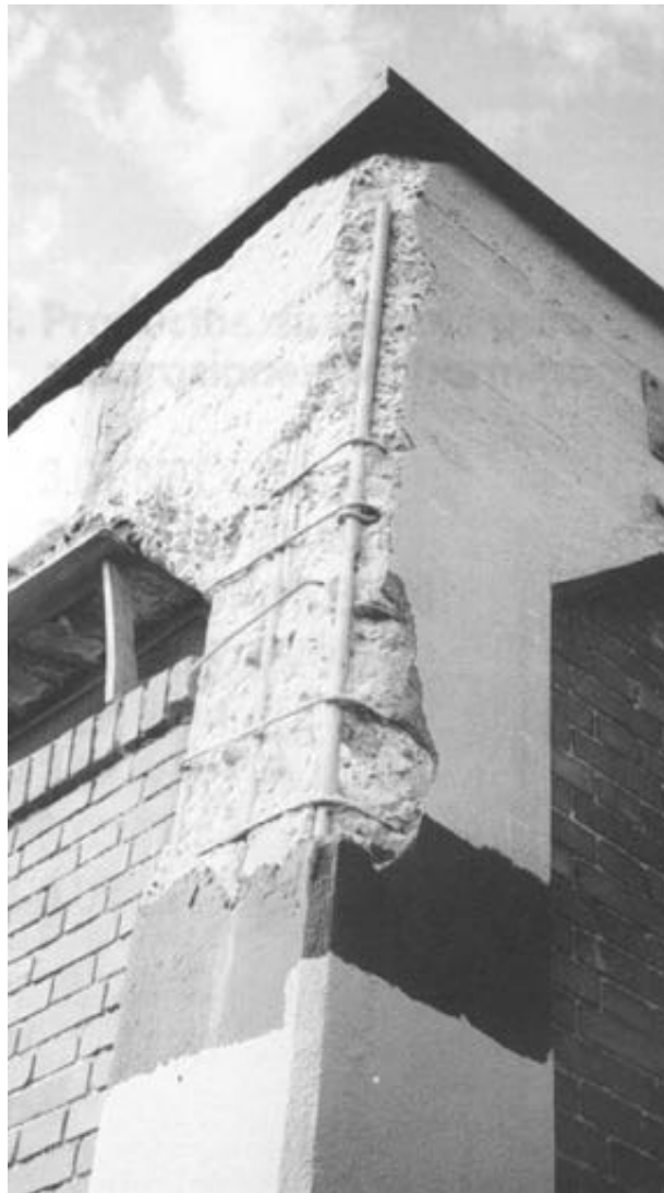
Ejemplo de reparación de pilar en esquina: zona superior saneada; zona inferior reparada.
