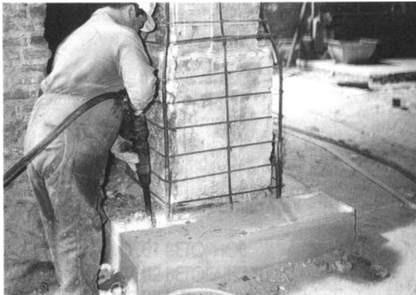
Anclaje de las nuevas armaduras de refuerzo en la zapata mediante resina epoxi
