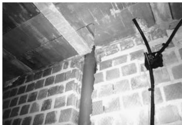
Perforación de viga plana (izqda) y de vigueta (drcha) para paso de bajantes
