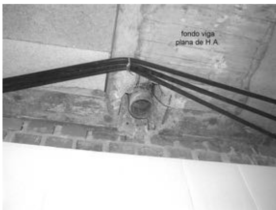
Perforación de viga plana (izqda) y de vigueta (drcha) para paso de bajantes
