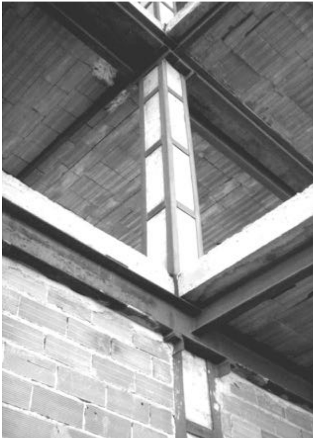
Ejemplo de sustitución funcional de una estructura de H.A. mediante perfilera de acero laminado
