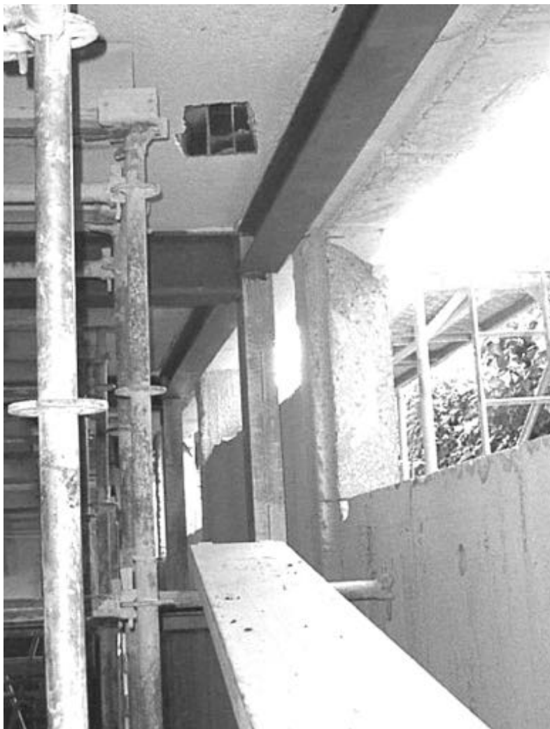
Sustitución de un pórtico de fachada: posteriormente a la ejecución del nuevo pórtico, se demuele el existente y se produce la puesta en carga
