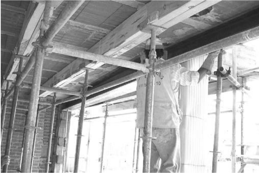
Apeo de estructura: el apeo mediante sopandas permite descargar a la viga del peso de los forjados, permitiendo efectuar la reparación de aquella.
