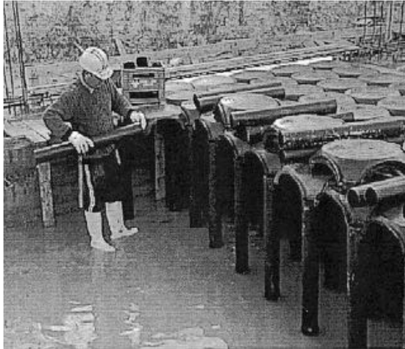
Figura n ° 33: Drenaje de soleras con casetones plásticos.
