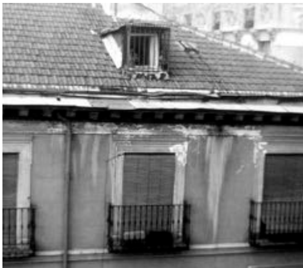
Figura n° 63: Desprendimiento de bajante
