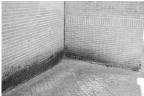
Figura n ° 45: Humedades de escorrentía en zonas inferiores.
