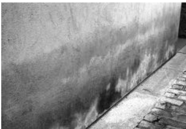
Figura n° 7: Grados de capilaridad
