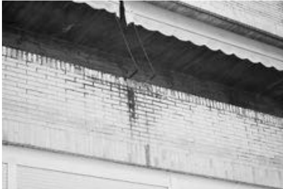
Figura n° 39: Oxidaciones
