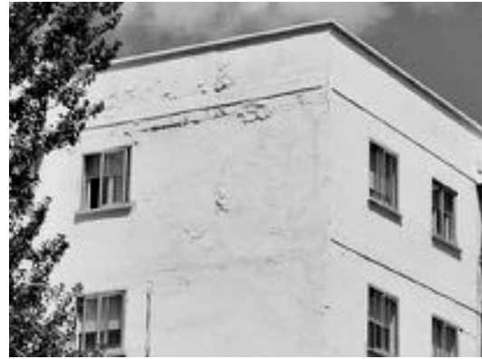
Figura n ° 48: Humedad de absorción en peto.
