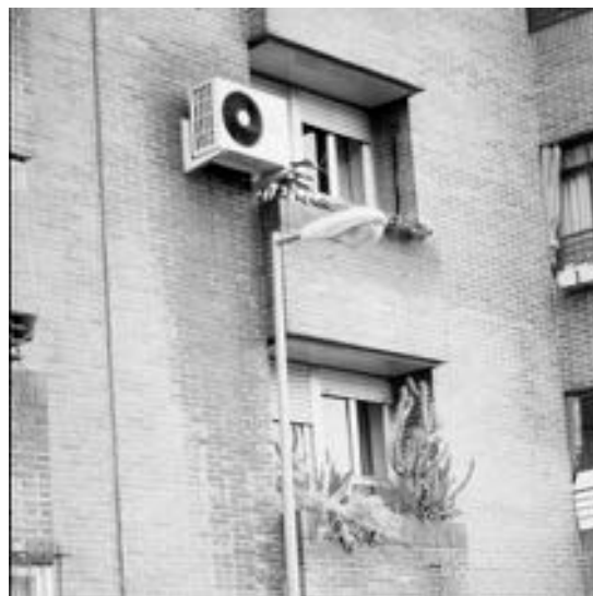
Figura n: 64 Humedades generadas por aparatos superpuestos
