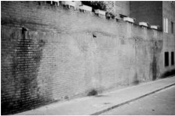
Figura n ° 47: Humedades de absorción por desagües.
