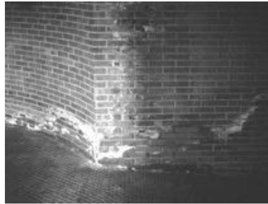
Figura nº 12: Eflorescencias por capilaridad
