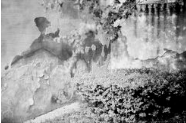
Figura nº 11: Muro afectado por capilaridad
