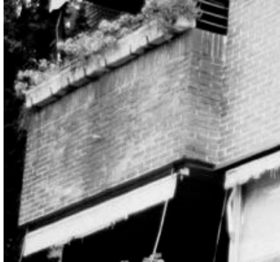
Figura n ° 49: Humedad por elementos sobrepuestos.
