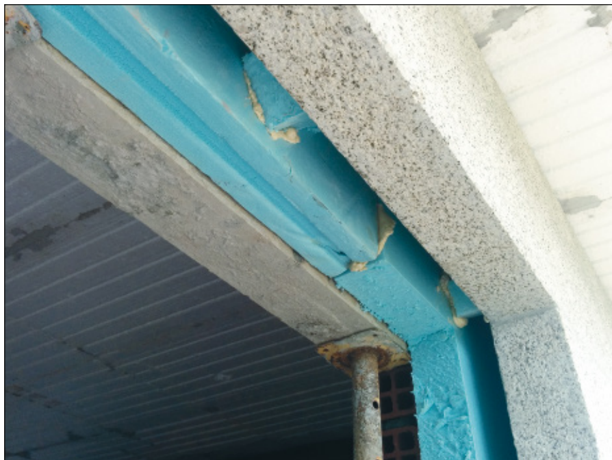
-Imagen M- Colocación de aislamiento de poliestireno extruido separado de la hoja exterior con distanciadores del mismo material (Foto: M. Rañó Rodríguez)
