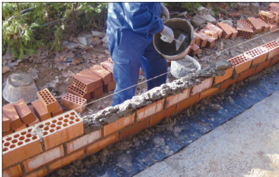
-Imagen C- Colocación de lámina impermeabilizante en el arranque de fachada en planta baja
