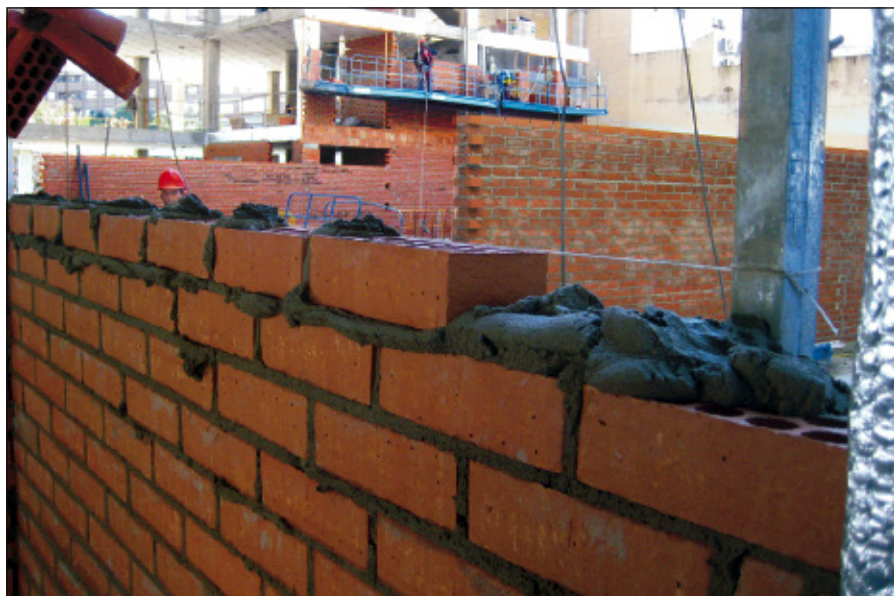
-Imagen E- Colocación de ladrillos en una hilada de la hoja exterior
