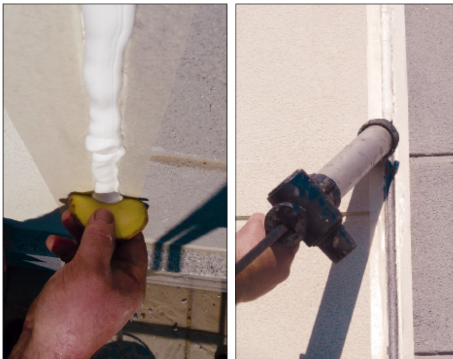
-Imagen J- Ejecución del sellado de una junta de dilatación de fachada. Aplicación del cordón y allanado superficial de este.
