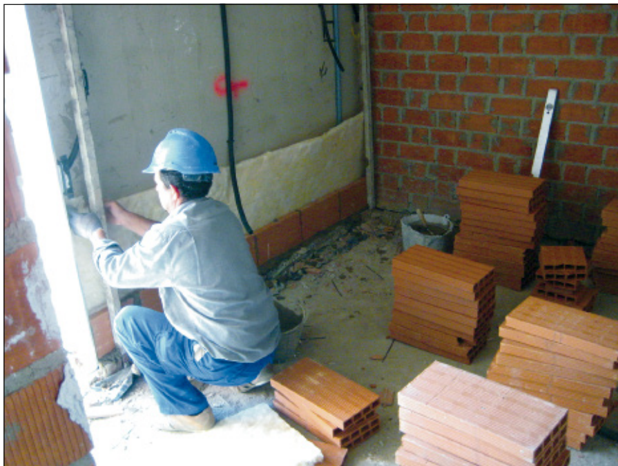
-Imagen N° Levante de la hoja interior de una fachada, con ladrillo hueco simple
