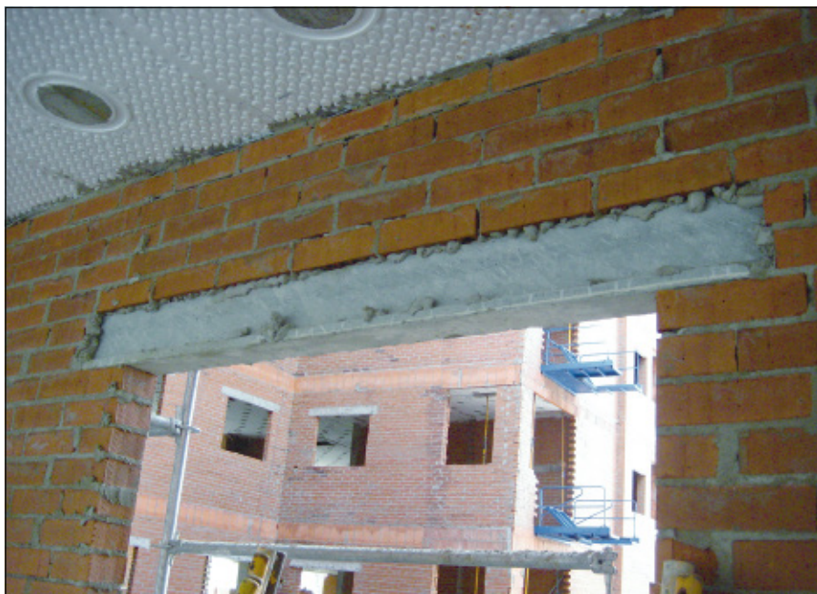
-Imagen I- Colocación de dintel en la hoja exterior de una fachada
