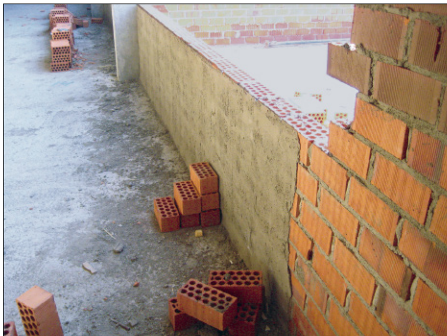
-Imagen K- Vista interna de la hoja exterior, la cual se encuentra parcialmente enfoscada con el embastado intermedio
