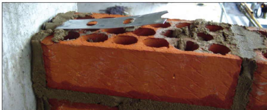
-Imagen G- Colocación de fijaciones de enganche entre la hoja exterior y los pilares. En foto superior con “armadura de amarre”; en la foto inferior con “flejes”
