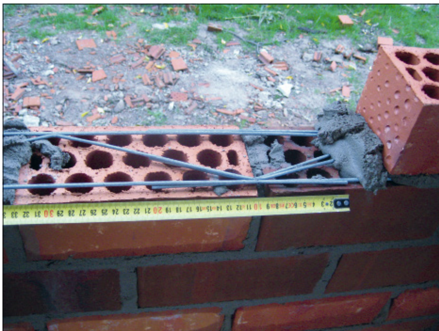
-Imagen F- Colocación de armadura en forma de celosía, en una junta horizontal de la hoja exterior de la fachada
