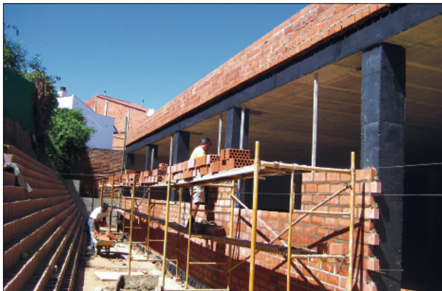
-Imagen D- Levante general de una fachada con ladrillo cerámico perforado
