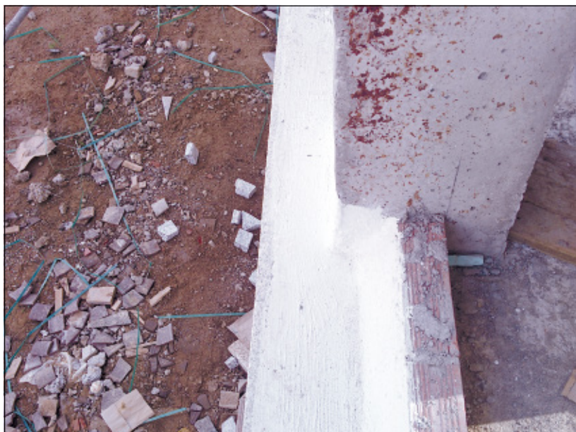
-Imagen L- Realización de una canaleta en la parte inferior de donde irá situada la cámara de aire de una fachada (Foto: M. Rañó Rodríguez)
