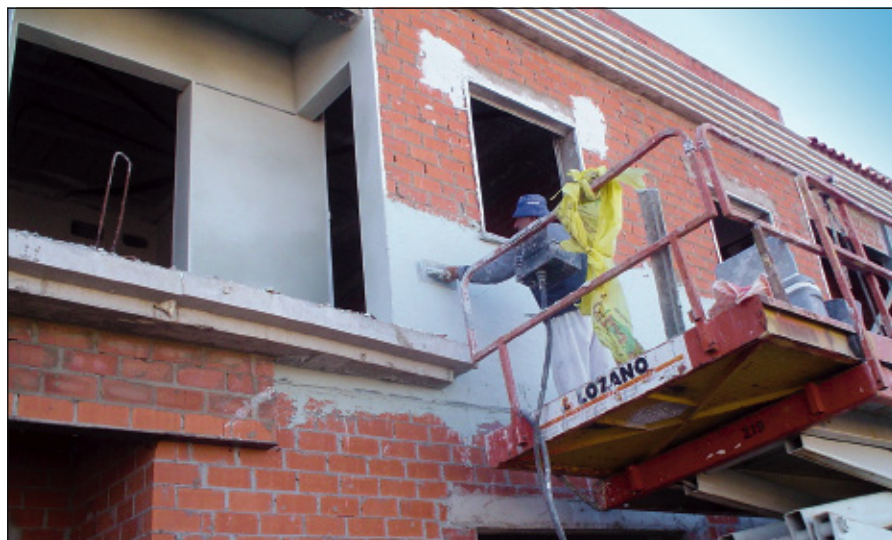
-Imagen B- Ejecución del revestimiento exterior con mortero monocapa
